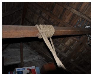
afb. 26 Dakconstructie, houten trek balk
